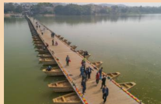
【贛州宋代古浮橋】
